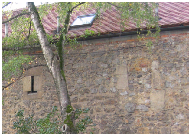
Slika 67. Strelna lina ter zazidano okno na Vodnikovi ulici.
