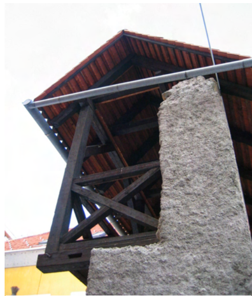
Slika 10. Stranski prerez celjskega obzidja z rekonstrukcijo obrambnega hodnika in strehe.
