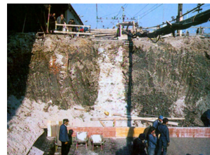
Slika 20. Ob gradnji podhoda pod prvim tirom železniške postaje.
