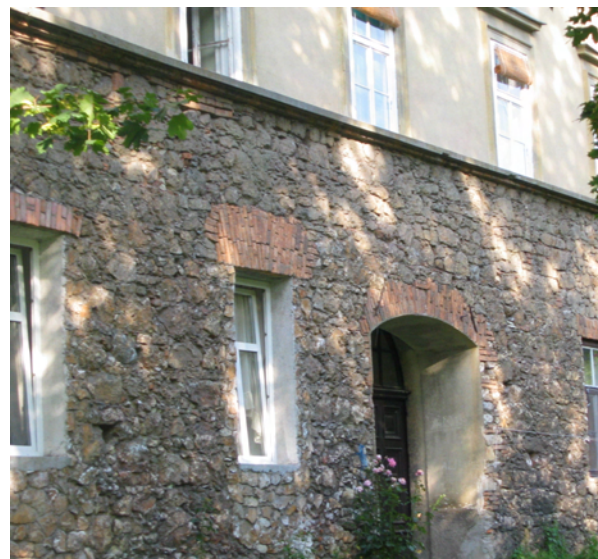
Slika 75. Južna stranica obzidja služi tudi kot fasada stanovanjskim hišam.
