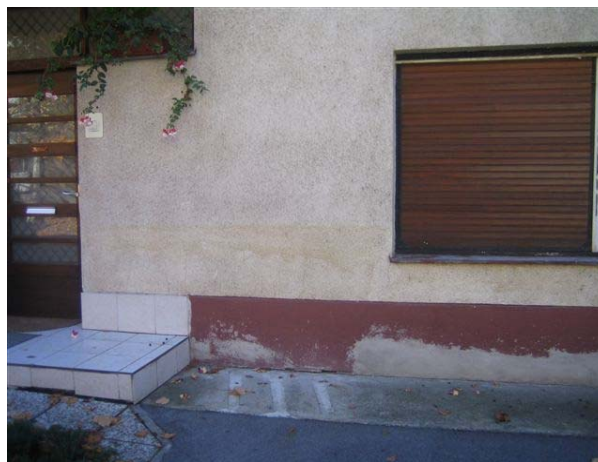
Slika 6: Posledice zadnje poplave na Špici še vedno niso sanirane Foto: V. Šoster, marec 2009
