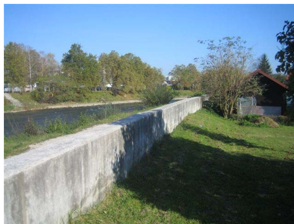
Slika 23: Protipoplavni zid v Liscah Foto: V. Šoster, oktober, 2008
